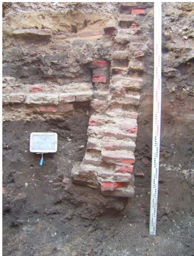
Afbeelding 89: verzakte middeleeuwse gevel en dwarsmuur in het noordwestprofiel. Boven in het profiel is nog de bakstenen vloer te zien van het 18/19 e -eeuwse pandje.
